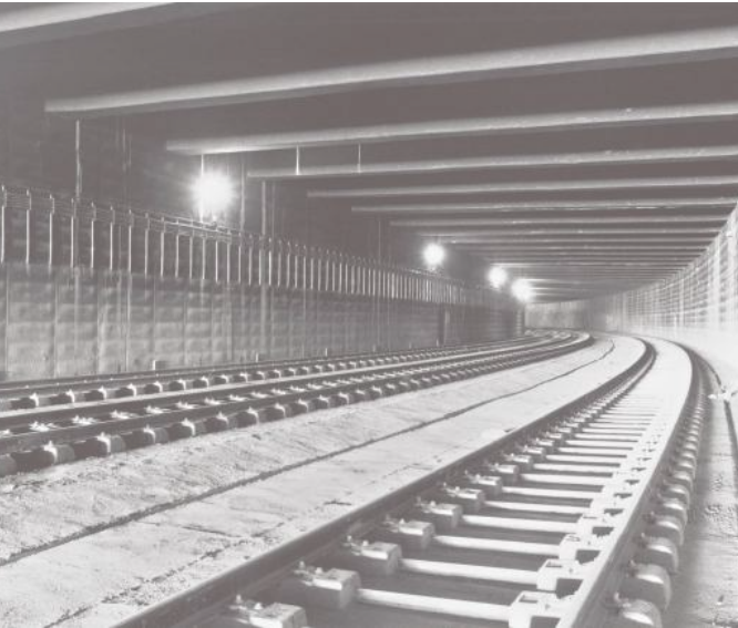
Vías subterráneas del ramal ferroviario de Glòries.
